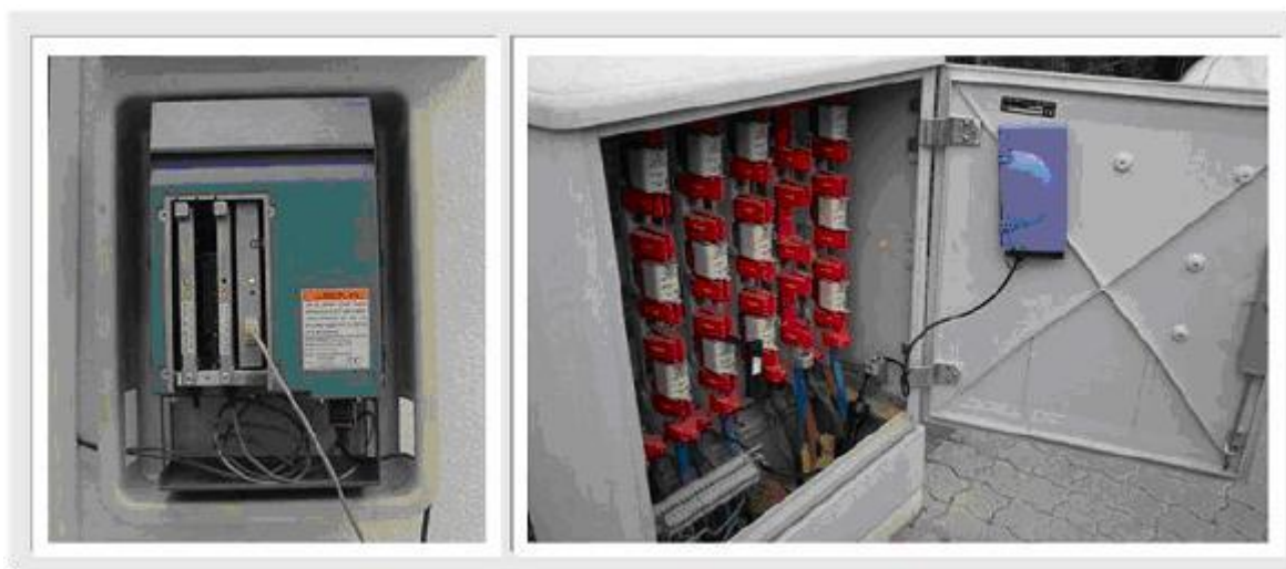
شکل (۲-۴): نمونه‌ای از دو تکرار کننده در اتاق کنتور و کابینت خیابان ۲
